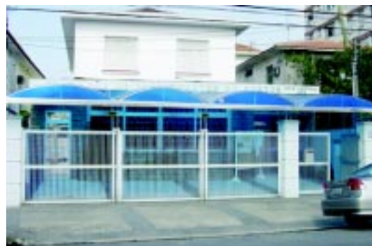
Sede atual da APP, localizada na rua Oswaldo Cruz, no bairro do Boqueirão, em Santos
