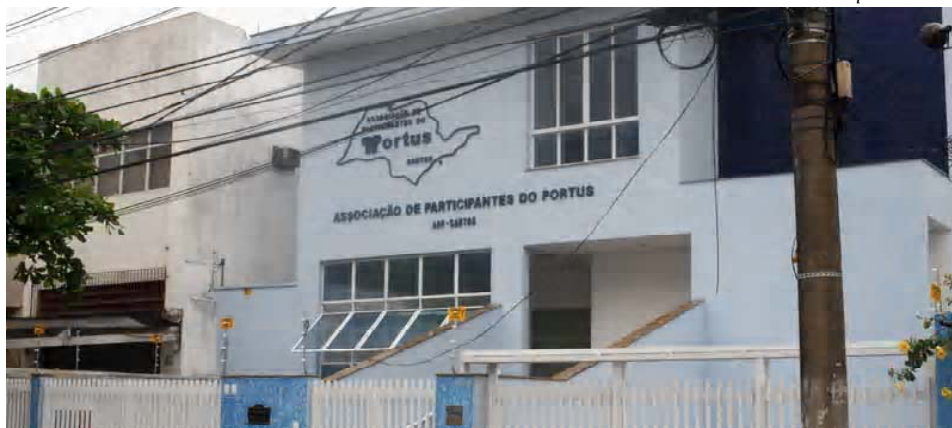
A obra está em fase de acabamento para a liberação da “Carta de Habite-se”, expedida pela Prefeitura e vistoria do Corpo de Bombeiros
